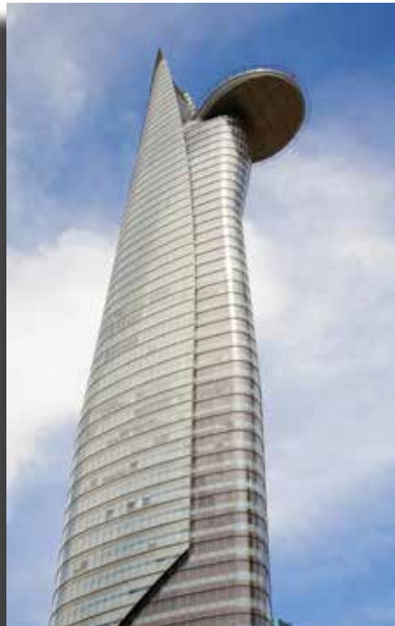
Bitexco Tower Hồ-Chio-Minh, Vietnam Завершено в 2010 г. Thermalbond® V2200
